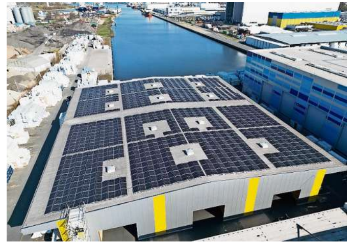
Die PV-Module auf dem Dach der Halle 17 reduzieren deutlich den CO 2 -Ausstoß. Foto: energiekonsens
