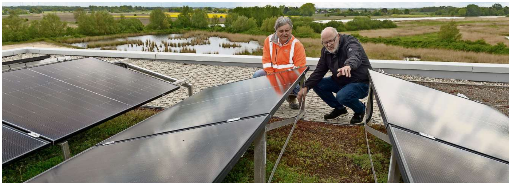
Heinfried Becker, energiekonsens (rechts) und Thorsten von Döhlen, Projektleiter der BEAN, blicken auf die fertigen Module auf dem Dach des Luniq.
