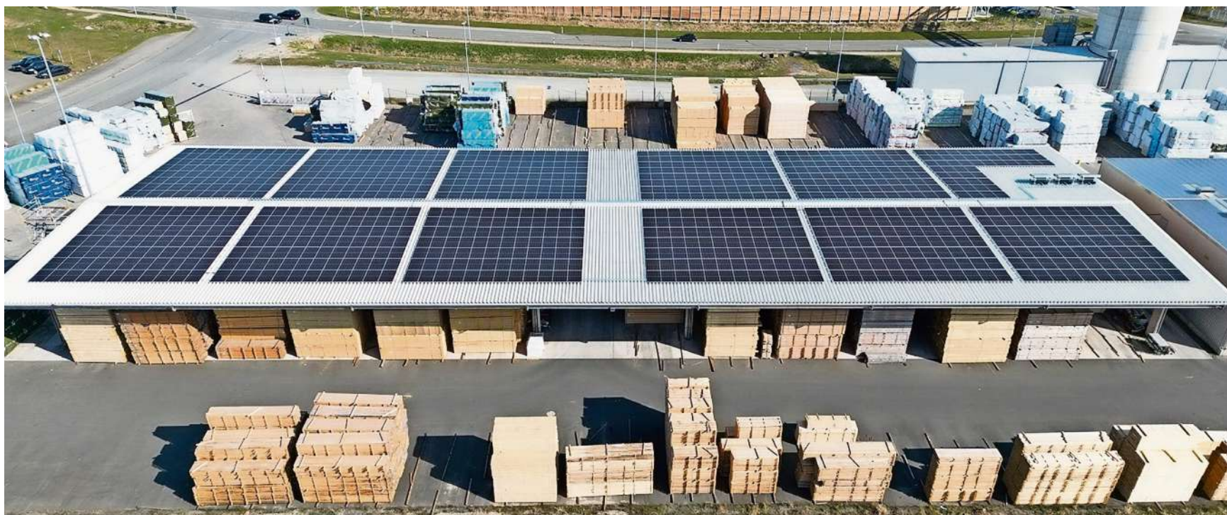
Großflächig mit Photovoltaik ausgestattet: das Dach der Halle 18, in der sich das Brettschichtwerk befindet. Foto: energiekonsens
