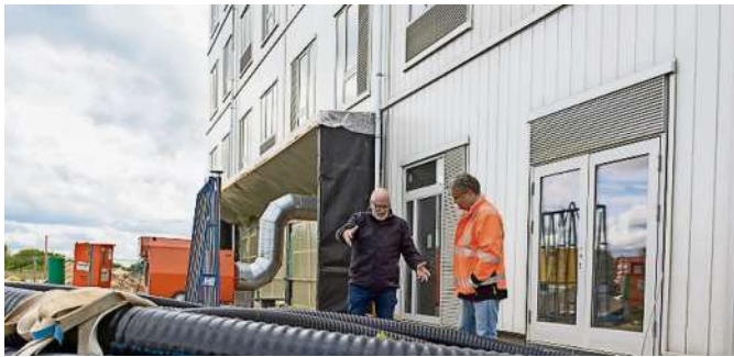
Becker (links) und von Döhlen im Baustellengespräch am Luniq-Gebäude. Fotos: Schimanke/energiekonsens
